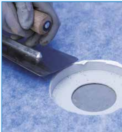
Ostateczne uszczelnianie elementu odpływowego
