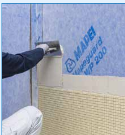
Montaż płytek ściennych
