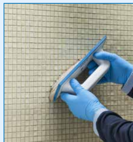
Wypełnianie spoin spoiną epoksydową
