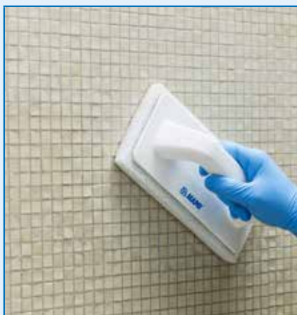
Wstępne profilowanie spoin wilgotną pacą Scotch-Brite®
