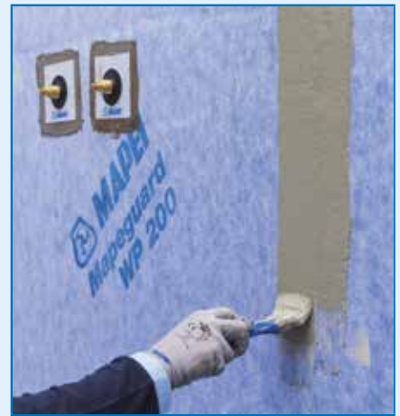
Aplikacja kleju MAPEGUARD WP ADHESIVE przed przyklejeniem taśmy MAPEGUARD ST w celu uszczelnienia łączenia między arkuszami maty
