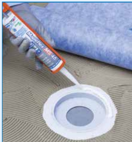
Aplikacja uszczelniacza hybrydowego MAPEFLEX MS 45 na element odpływowy
