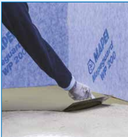
Aplikacja kleju cementowego
