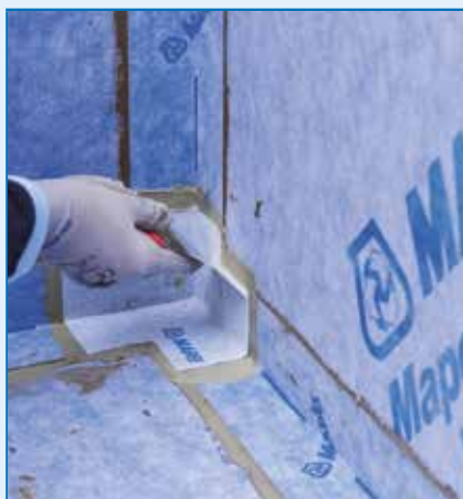
Przyklejanie narożnika wewnętrznego MAPEGUARD IC przy użyciu kleju MAPEGUARD WP ADHESIVE
