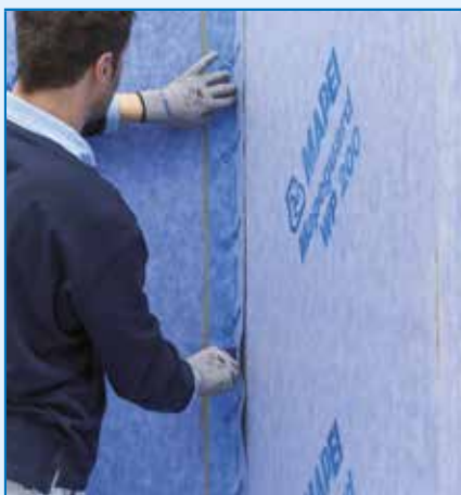
Przyklejanie taśmy MAPEGUARD ST w narożu przy użyciu kleju MAPEGUARD WP ADHESIVE
