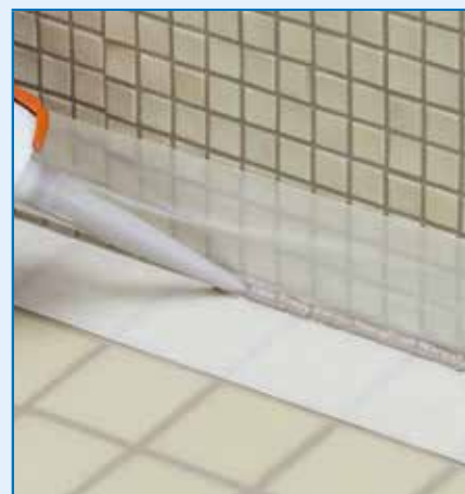
Uszczelnianie narożników silikonem MAPESIL AC
