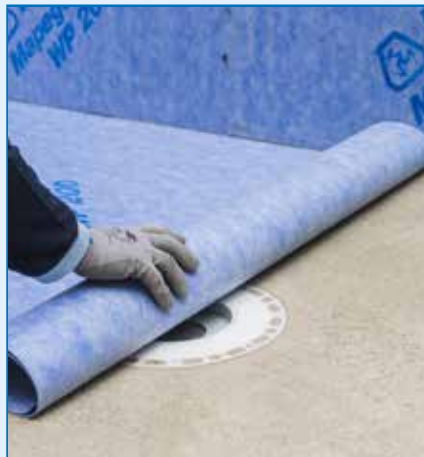
Próbne rozwijanie maty w celu sprawdzenia pozycjonowania miejsca odpływu
