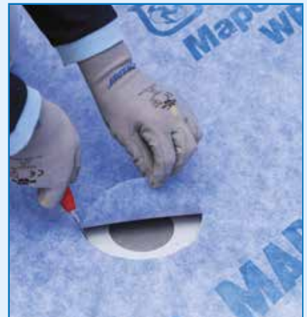
Wycinanie otworu w miejscu odpływu
