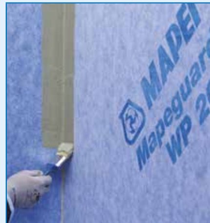
Aplikacja kleju MAPEGUARD WP ADHESIVE przed przyklejeniem taśmy MAPEGUARD ST w celu uszczelnienia łączenia między arkuszami maty
