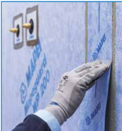
Uszczelnianie połączeń arkuszy maty przy użyciu taśmy MAPEGUARD ST
