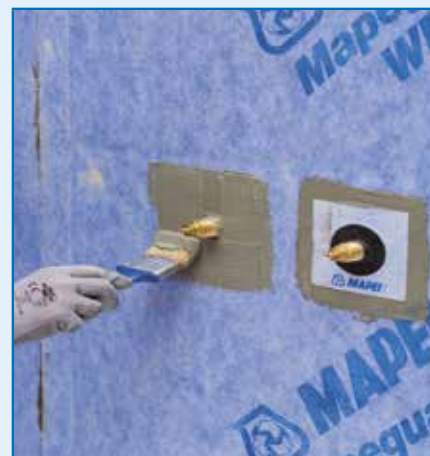
Przyklejanie mankietów uszczelniających MAPEGUARD PC przy użyciu kleju MAPEGUARD WP ADHESIVE
