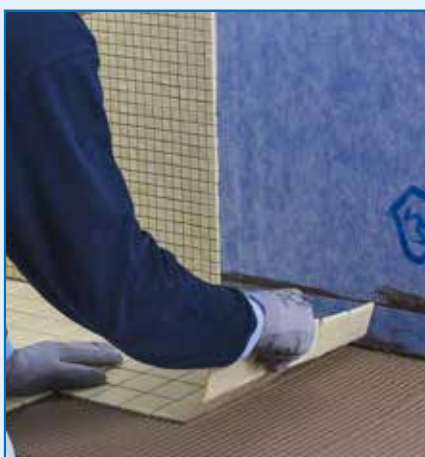
Montaż płytek podłogowych przy użyciu kleju cementowego
