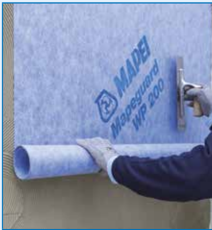
Przyklejanie pierwszego arkusza maty MAPEGUARD WP 200 na ścianie
