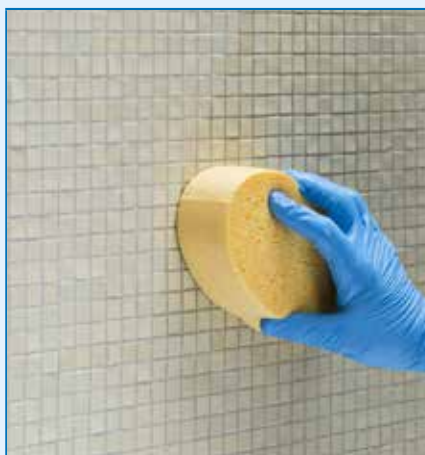
Czyszczenie i profilowanie spoin twardą gąbką celulozową
