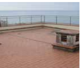
Podłoże przygotowane pod aplikację membrany
