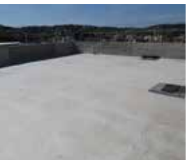
Podłoże przygotowane pod aplikację membrany
