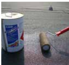
Aplikacja warstwy gruntującej
