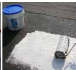
Aplikacja membrany hydroizolacyjnej
