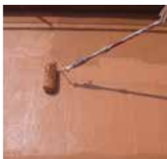
Aplikacja warstwy hydroizolacyjnej
