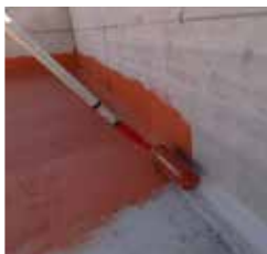
Aplikacja warstwy hydroizolacyjnej
