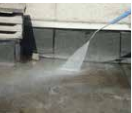
Czyszczenie podłoża
